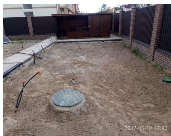
Рис. 5. Встановлена каналізаційна система, виведено систему поливу.
