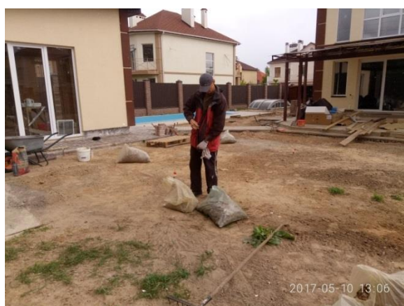
Рис. 4. Прибирання території після забудови.
